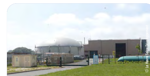
4 CENTRALE BIOGAZ DES HAUTES FALAISES
