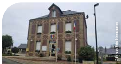
1 Mairie de Beurepaire
